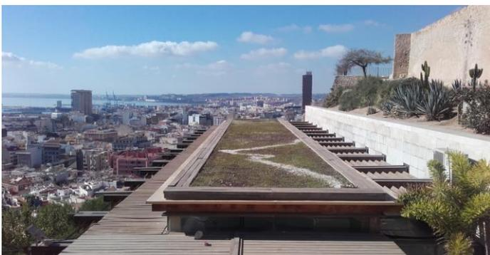
Figura 1.05. Cubierta verde extensiva en la azotea de un edificio de una planta en Alicante. Fotografía tomada por el autor el 10 de octubre de 2016.
