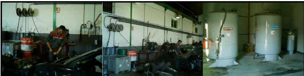
Imagen 1.4. Sistema de extracción de líquidos por aspiración (aceite, anticongelante y líquido de frenos). Fuente: Propia (2003).
