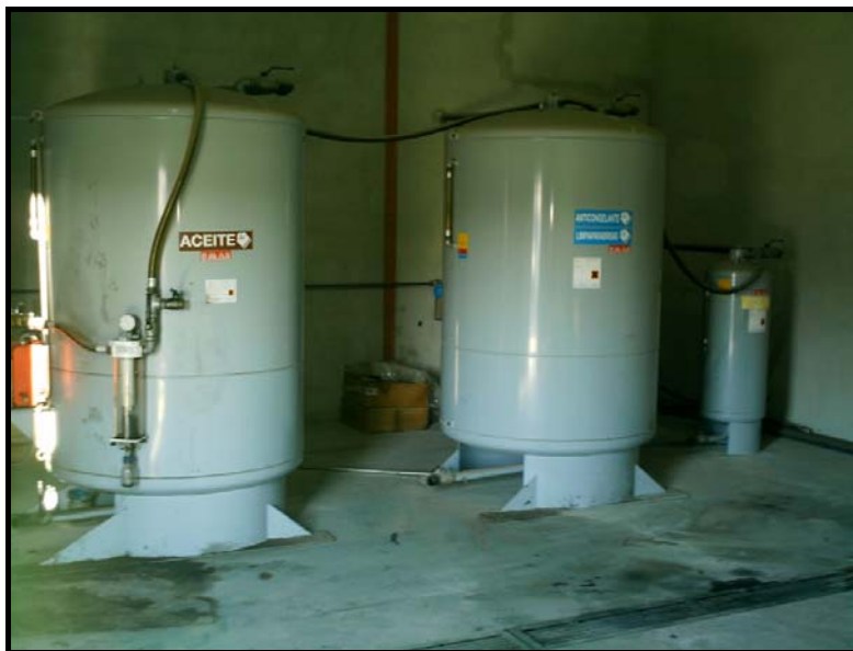
Imagen 5.3. Depósitos para recogida de Aceites, Anticongelante y Líquido de Frenos. Fuente: Propia (2003).
