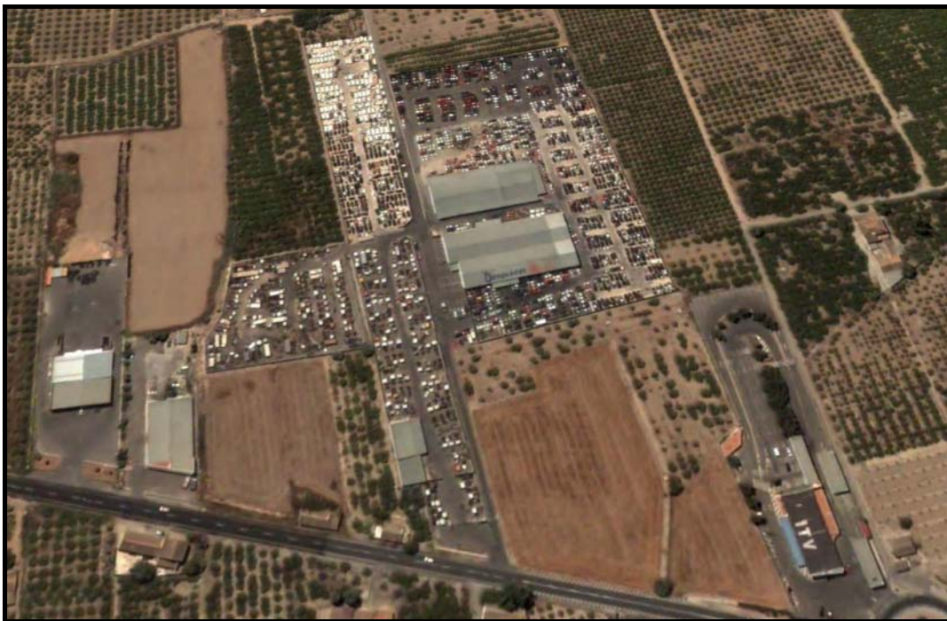
Imagen 1.1. Vuelo aéreo de desguace en suelo rústico. Fuente: Desguaces Mora, S.L. (2002).
