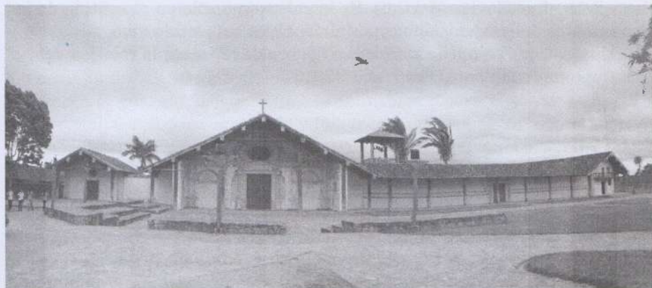
Figura 1. Iglesia y conjunto de edificaciones religiosas de la misión de San Javier. Fachada a la plaza. Se destacan los atrios porticados y galerías.
