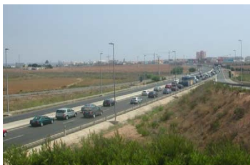
Fig. 39: Acceso rodado a La Manga del Mar Menor. Verano 2013. (Fuente: Imagen propia)
