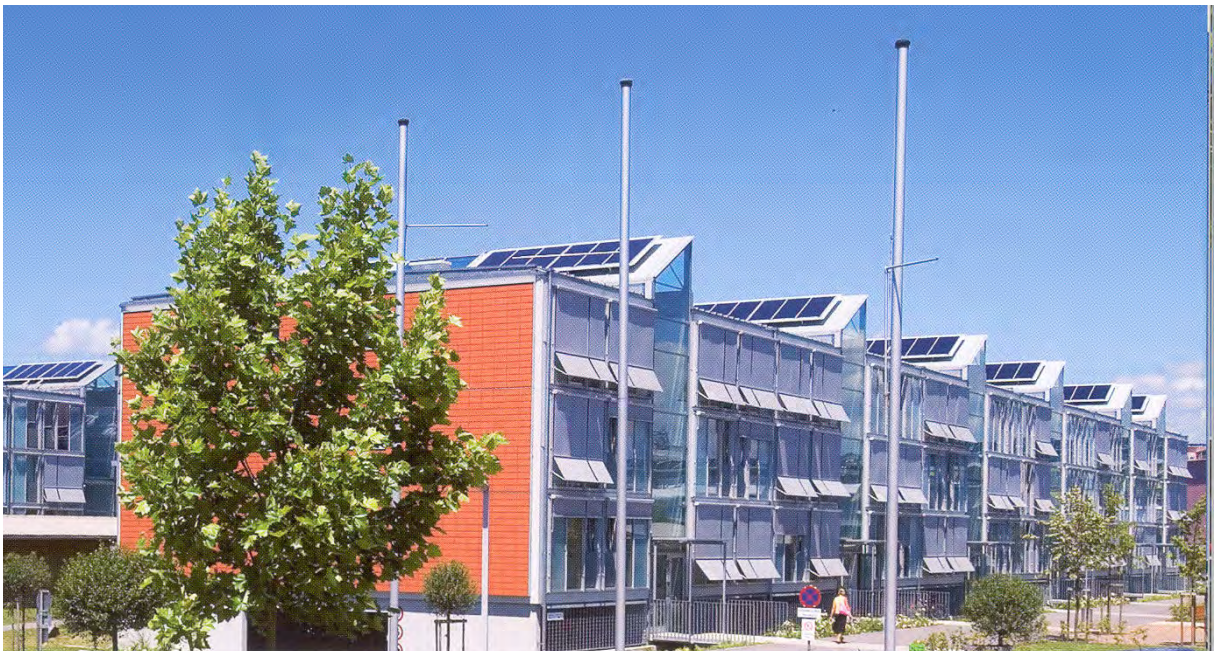
Figura 9. Sistema de energía solar en el ecobarrio de Linz, Austria. (Fuente: Edificio Residencial, Solar City, Linz (Austria), T. Herzog, 2005)
