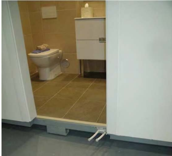
Figura 2.9.- Sifón en paramento vertical. Conspace, año 2015
