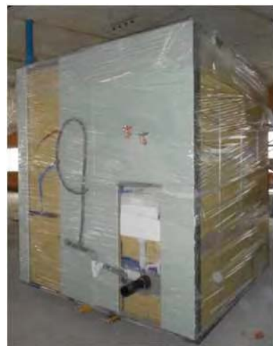
Figura 2.13.- Protección de cisterna con placa de cartón-yeso. Conspace, año 2015
