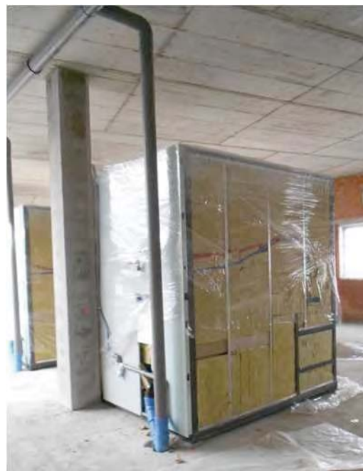
Figura 3.7.- Módulo de cuarto de baño prefabricado colocado en obra y conectado a la red de saneamiento. Hotel de Vigo, año 2013
