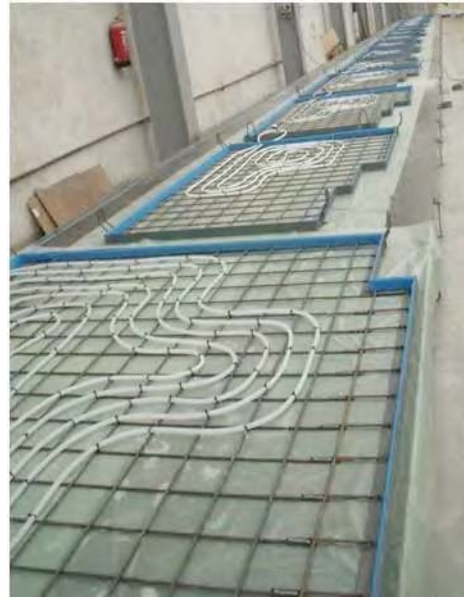
Figura 2.15.- Suelo radiante en módulos de baño prefabricado. Conspace, año 2015
