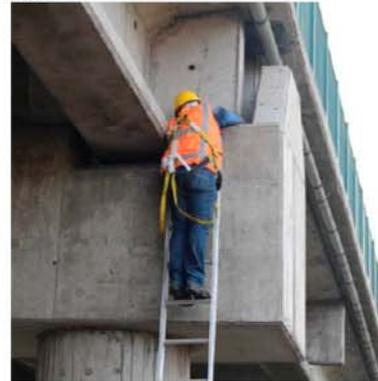
Figura 1. Instrumentación del puente Ibáñez. *Elaboración propia*
