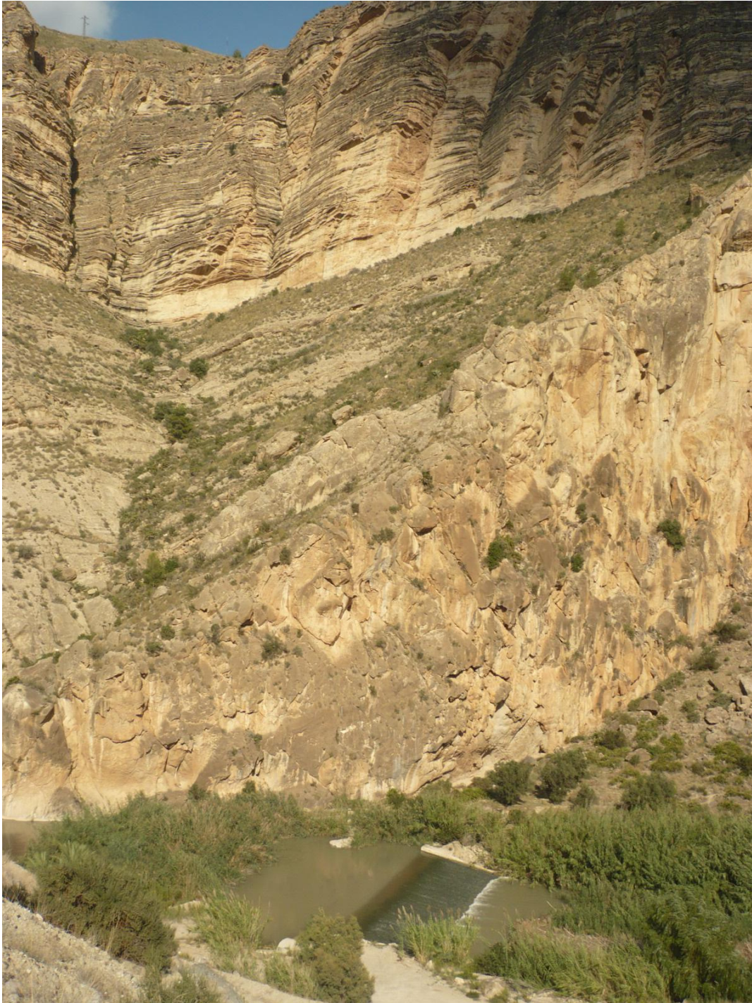
Figura 35. Vista aérea del azud de Ojós, aguas abajo de la presa.
